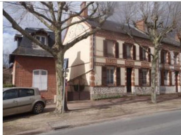
Vue du site (source : CEREMA, 2018)
