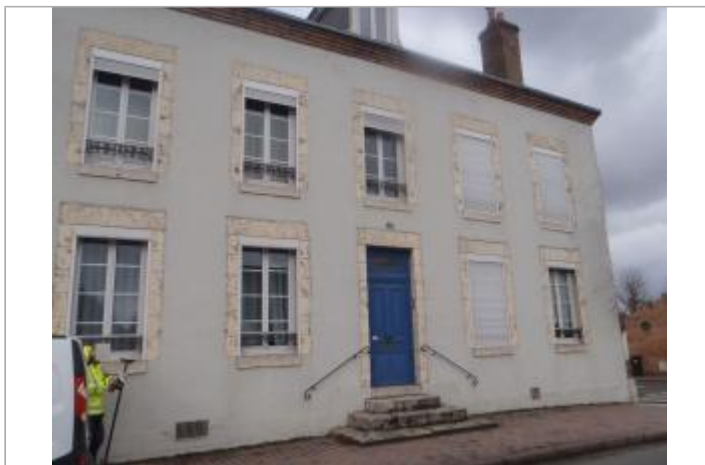
Vue du site (source : CEREMA, 2018)
