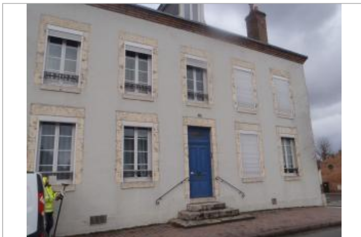
Vue du site (source : CEREMA, 2018)
