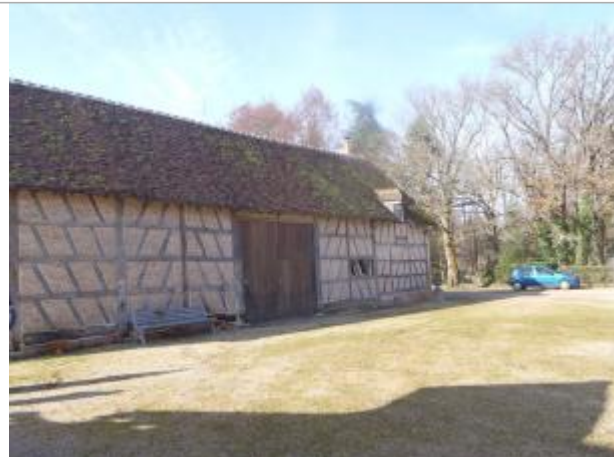
Vue du site (source : CEREMA, 2018)
