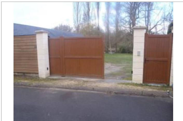
Vue du site (source : CEREMA, 2018)
