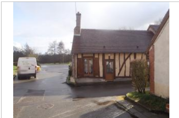
Vue du site (source : CEREMA, 2018)
