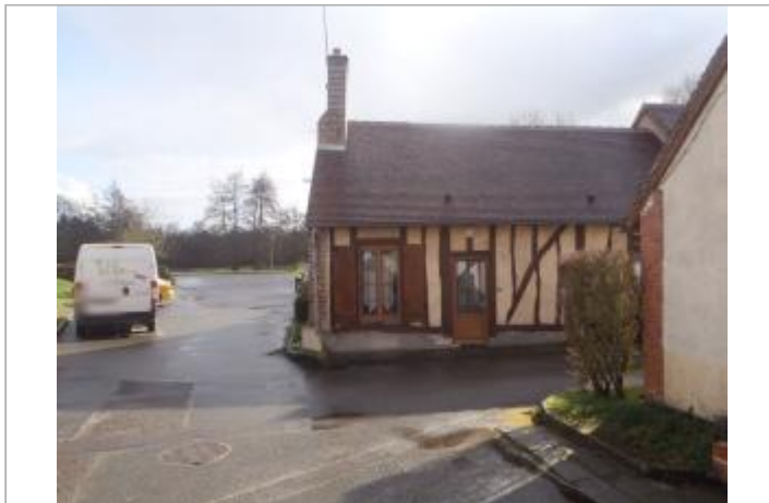
Vue du site (source : CEREMA, 2018)
