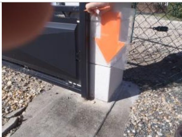
Vue du repère (source : CEREMA, 2018)
