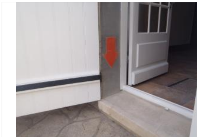
Vue du repère (source : CEREMA, 2018)
