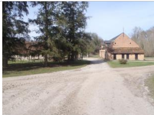
Vue du site (source : CEREMA, 2018)
