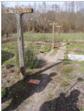
Vue du repère (source : CEREMA, 2018)
