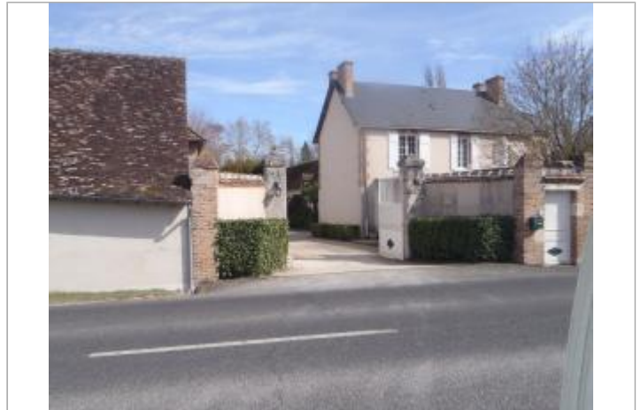
Vue du site (source : CEREMA, 2018)
