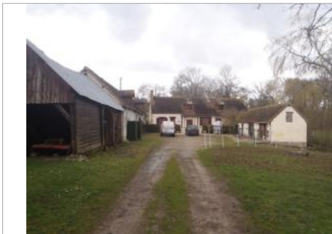
Vue du site (source : CEREMA, 2018)
