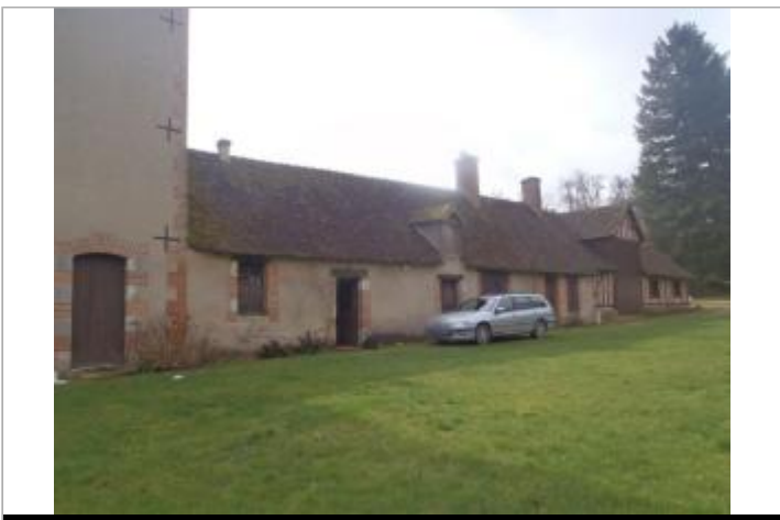
Vue du site (source : CEREMA, 2018)
