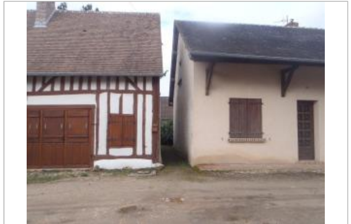
Vue du site (source : CEREMA, 2018)
