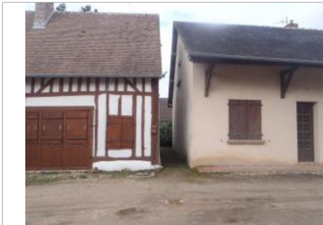
Vue du site (source : CEREMA, 2018)
