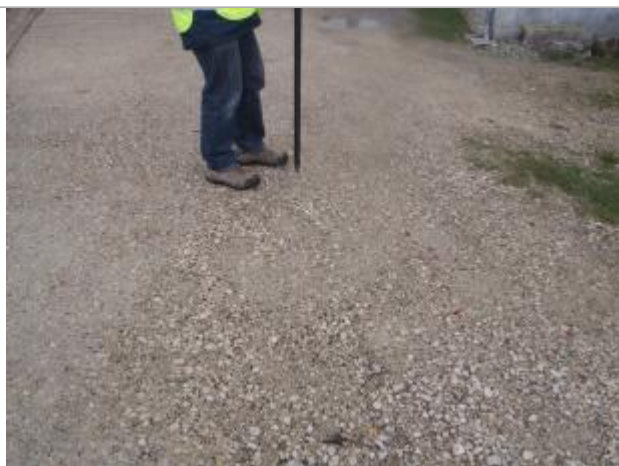
Vue du repère (source : CEREMA, 2018)
