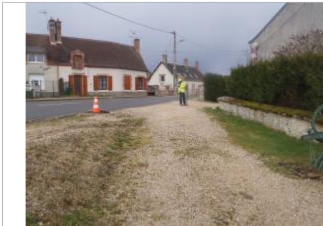
Vue du site (source : CEREMA, 2018)
