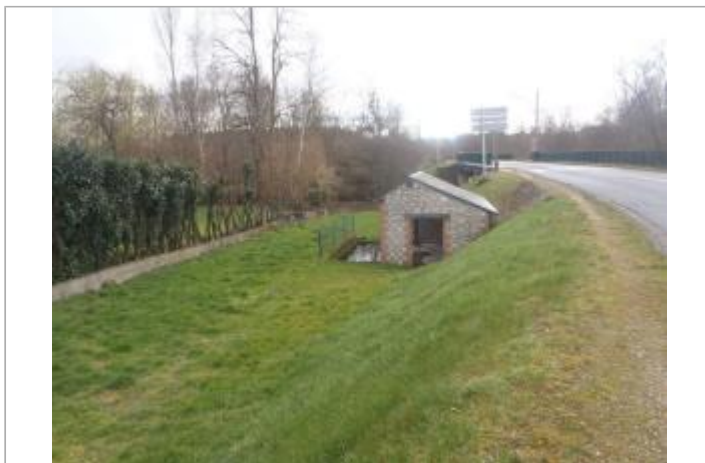
Vue du site (source : CEREMA, 2018)
