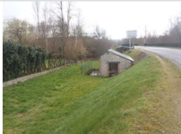
Vue du site (source : CEREMA, 2018)
