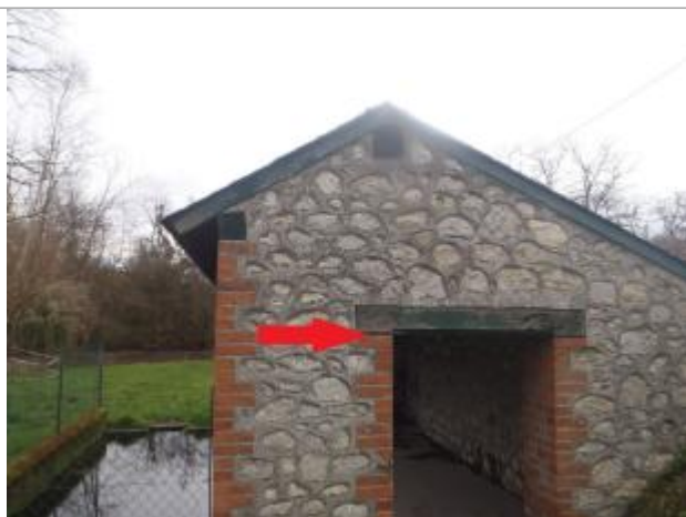
Vue du repère (source : CEREMA, 2018)
