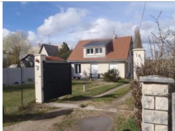
Vue du site (source : CEREMA, 2018)
