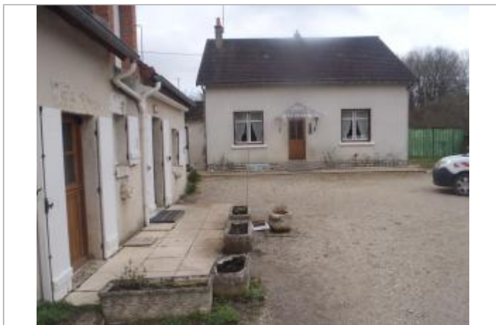
Vue du site (source : CEREMA, 2018)
