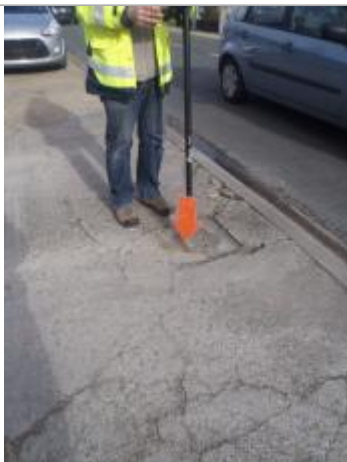
Vue du repère (source : CEREMA, 2018)
