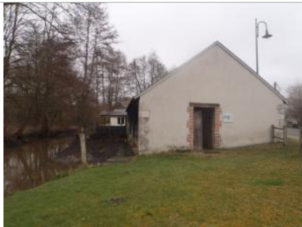
Vue du site (source : CEREMA, 2018)
