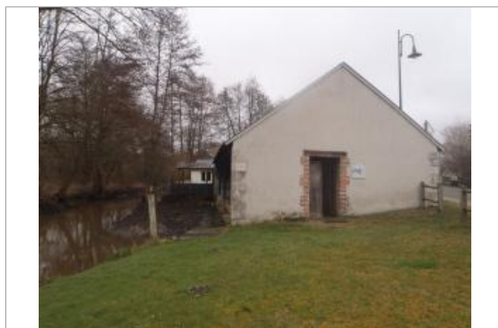
Vue du site (source : CEREMA, 2018)
