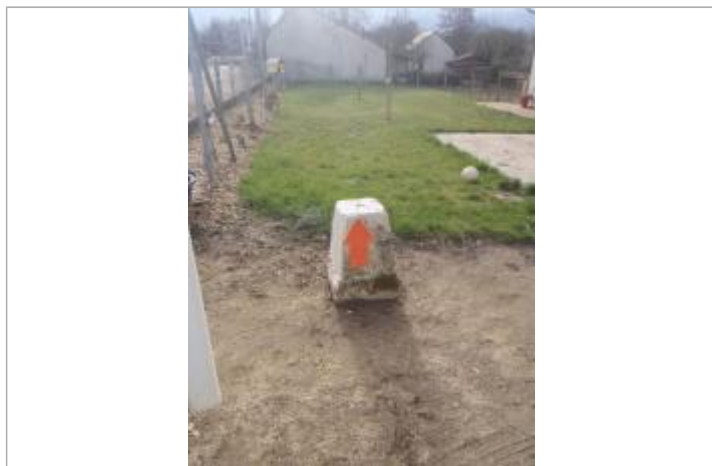
Vue du repère (source : CEREMA, 2018)
