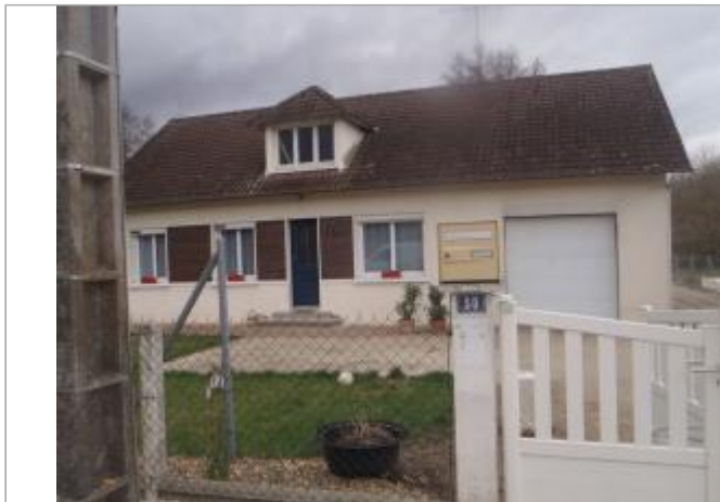
Vue du site (source : CEREMA, 2018)
