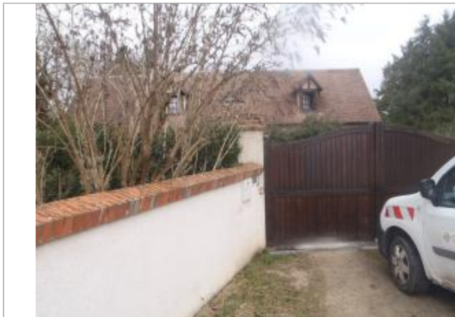
Vue du site (source : CEREMA, 2018)
