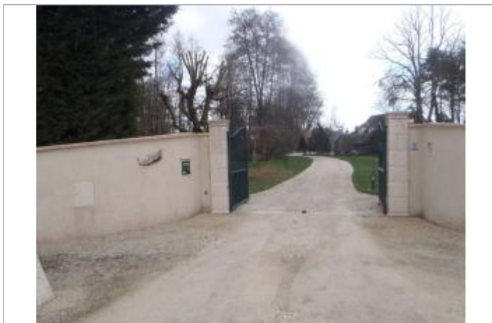
Vue du site (source : CEREMA, 2018)
