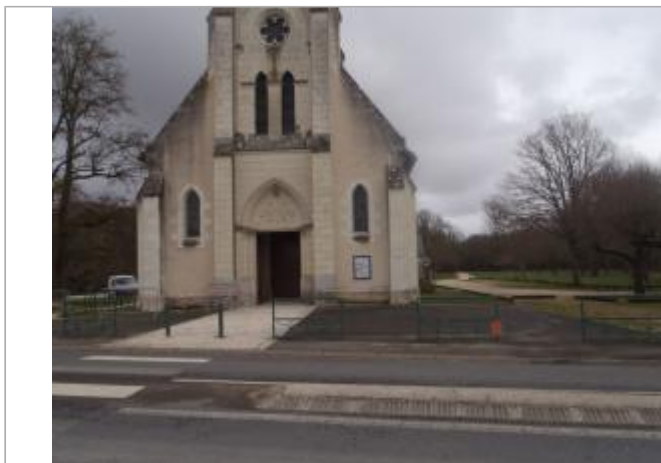
Vue du site (source : CEREMA, 2018)
