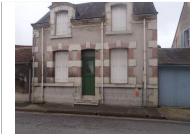
Vue du site (source : CEREMA, 2018)
