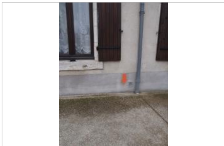
Vue du repère (source : CEREMA, 2018)
