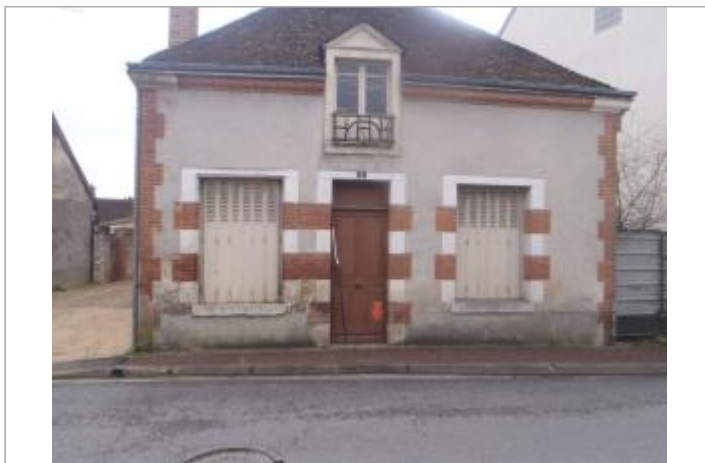
Vue du site (source : CEREMA, 2018)
