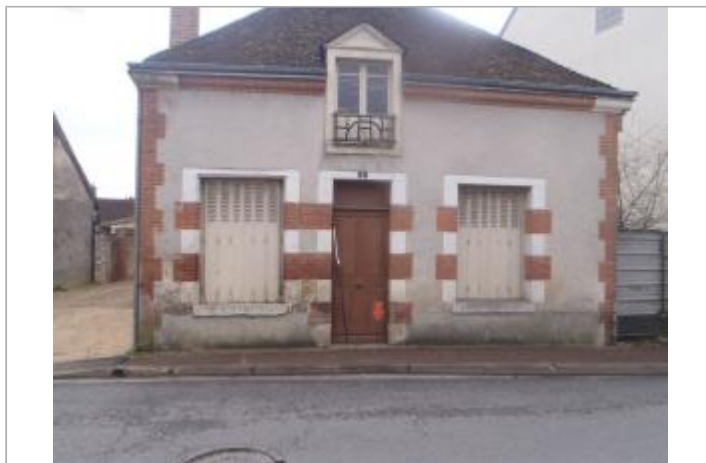
Vue du site (source : CEREMA, 2018)
