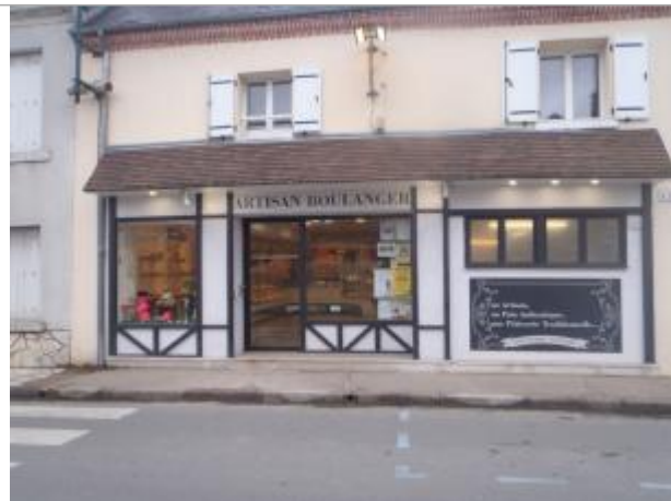
Vue du site (source : CEREMA, 2018)
