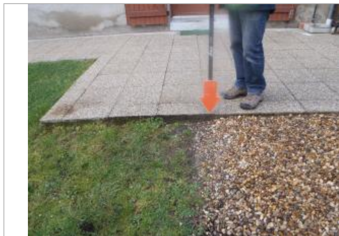
Vue du repère (source : CEREMA, 2018)
