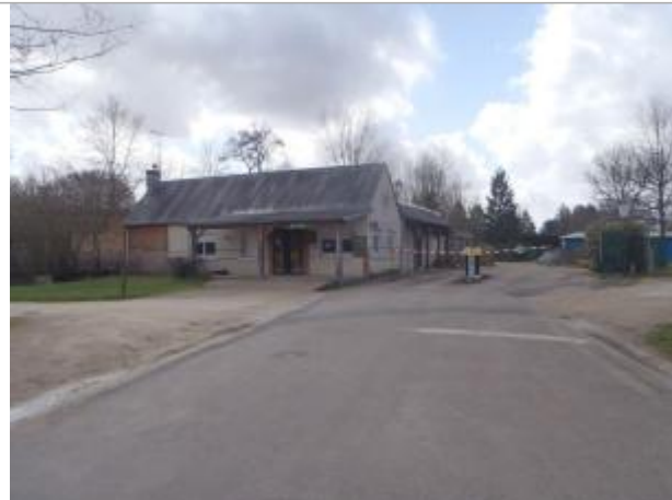
Vue du site (source : CEREMA, 2018)
