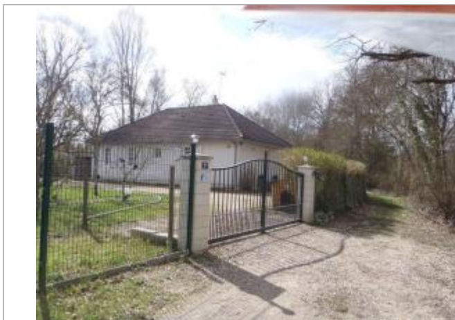
Vue du site (source : CEREMA, 2018)
