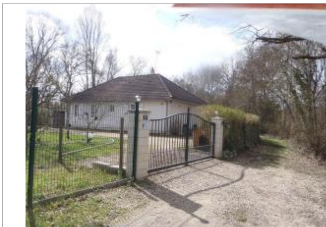
Vue du site (source : CEREMA, 2018)
