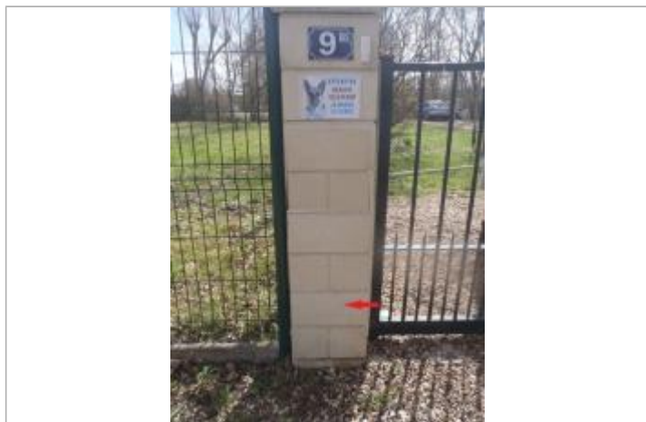
Vue du repère (source : CEREMA, 2018)
