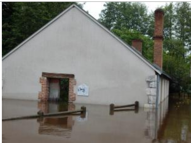
Vue du repère (source : CEREMA, 2018)
