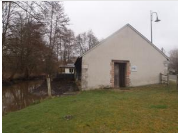
Vue du site (source : CEREMA, 2018)
