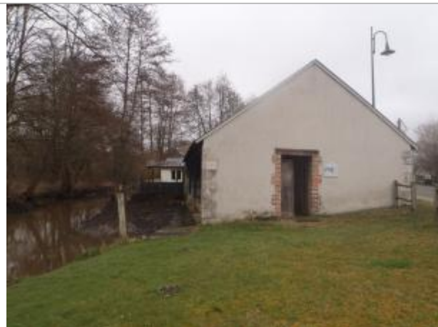
Vue du site (source : CEREMA, 2018)
