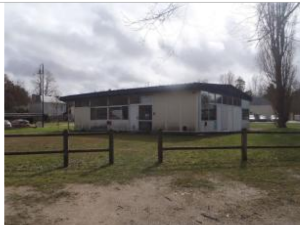
Vue du site (source : CEREMA, 2018)
