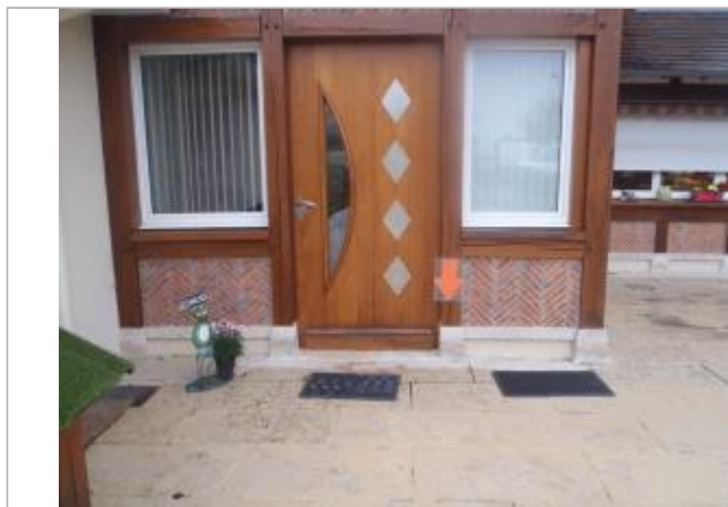
Vue du repère (source : CEREMA, 2018)
