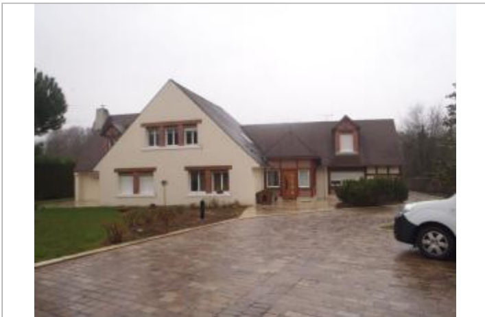
Vue du site (source : CEREMA, 2018)
