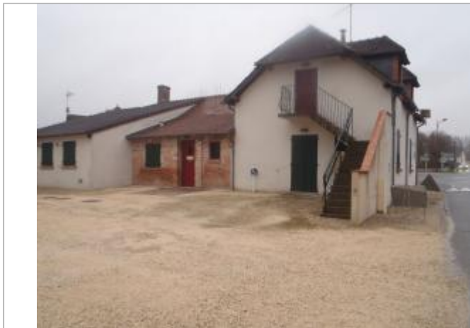
Vue du site (source : CEREMA, 2018)
