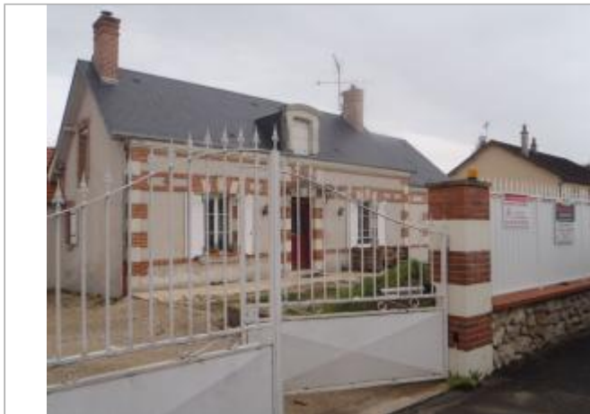
Vue du site (source : CEREMA, 2018)
