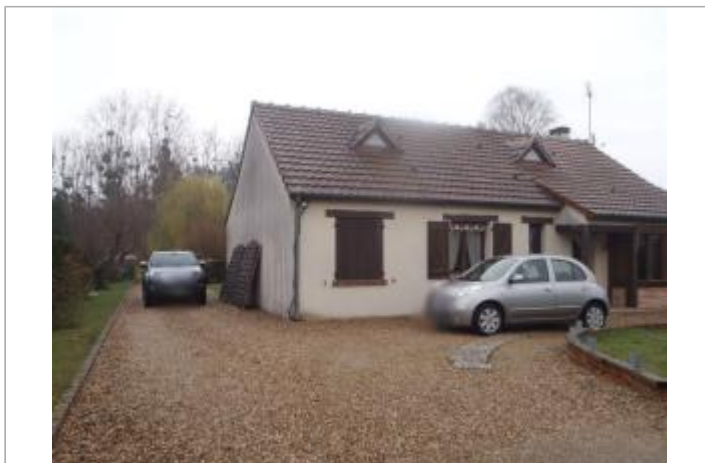
Vue du site (source : CEREMA, 2018)
