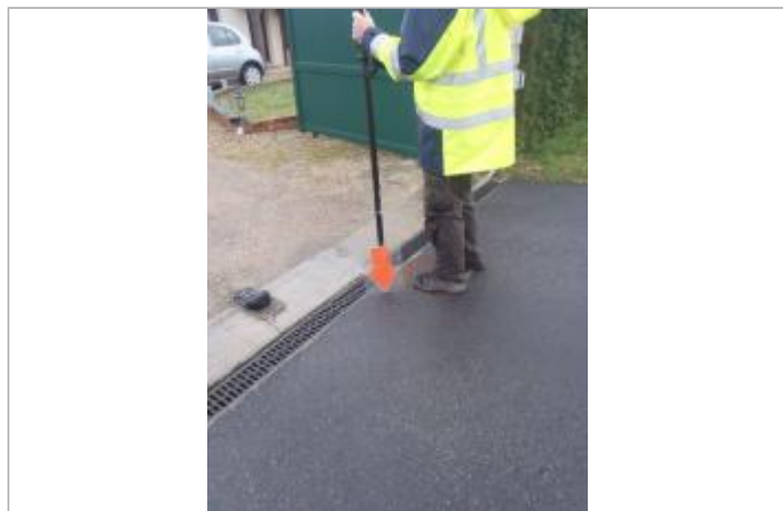
Vue du repère (source : CEREMA, 2018)
