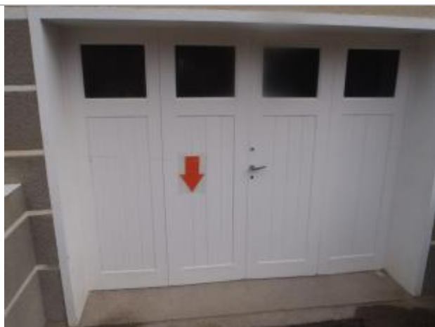
Vue du repère (source : CEREMA, 2018)
