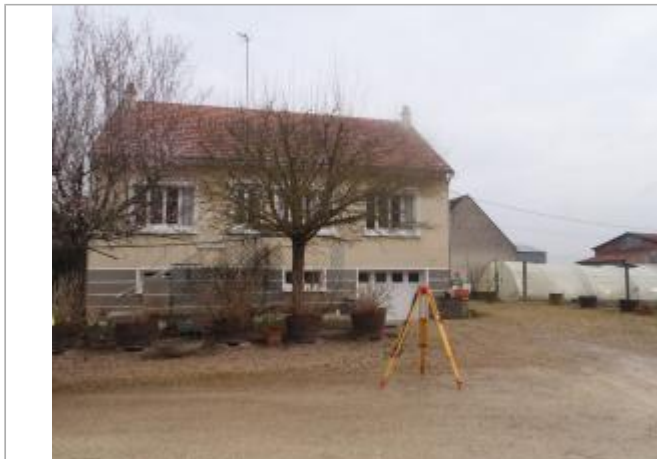
Vue du site (source : CEREMA, 2018)
