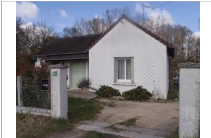
Vue du site (source : CEREMA, 2018)
