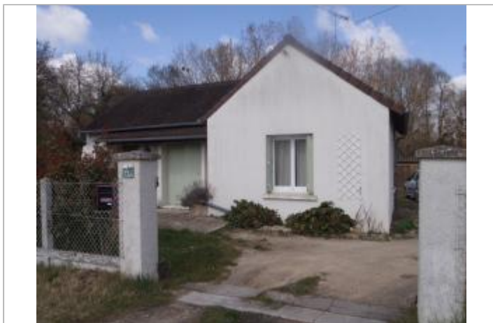
Vue du site (source : CEREMA, 2018)
