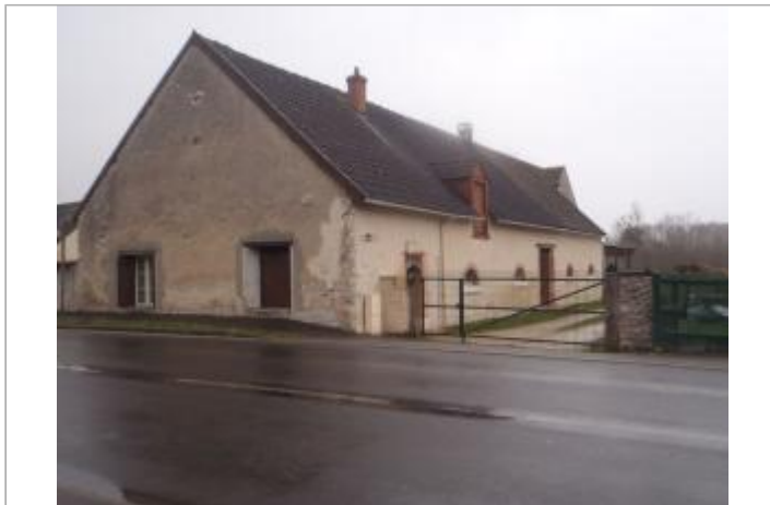
Vue du site (source : CEREMA, 2018)
