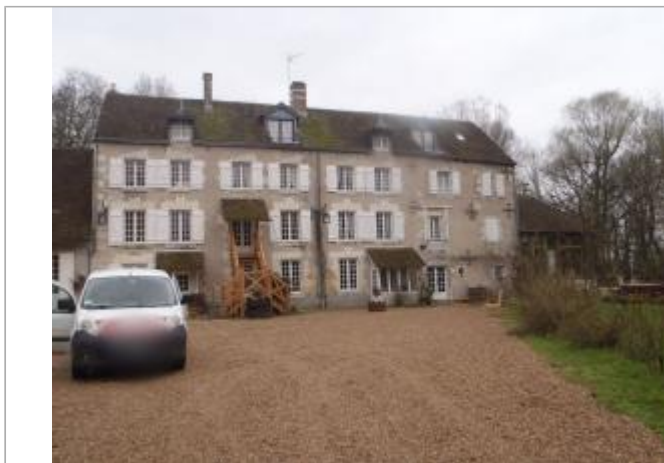
Vue du site (source : CEREMA, 2018)
