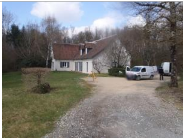
Vue du site (source : CEREMA, 2018)
