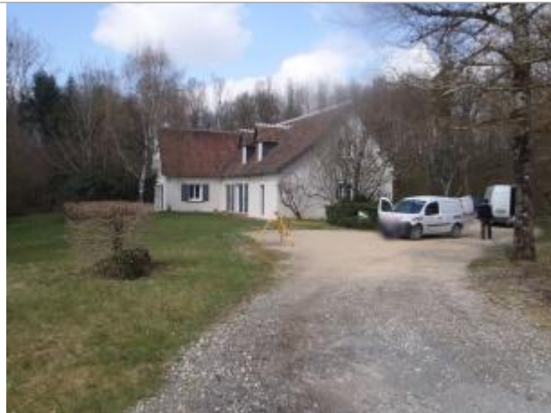
Vue du site (source : CEREMA, 2018)
