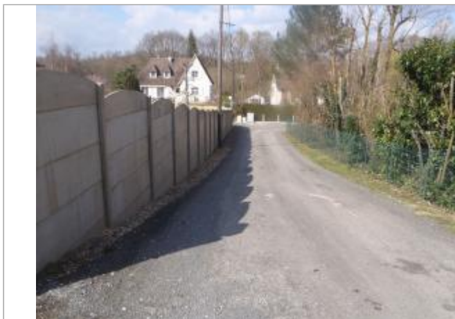
Vue du site (source : CEREMA, 2018)
