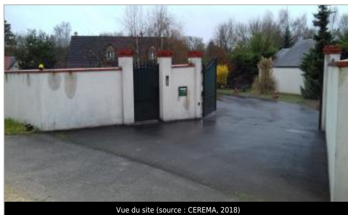
Vue du site (source : CEREMA, 2018)
