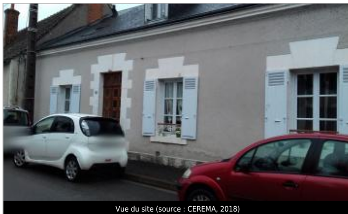
Vue du site (source : CEREMA, 2018)
