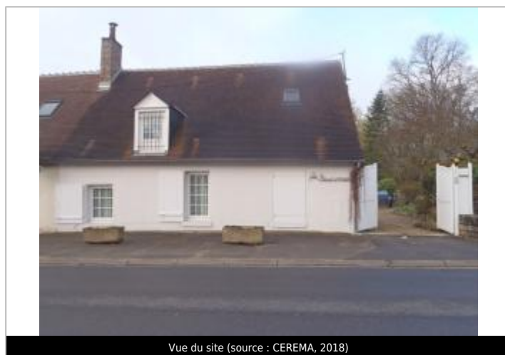
Vue du site (source : CEREMA, 2018)
