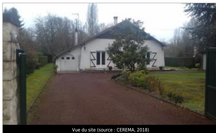
Vue du site (source : CEREMA, 2018)
