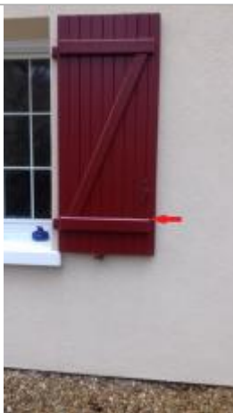
Vue du repère (source : CEREMA, 2018)
