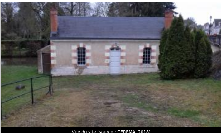
Vue du site (source : CEREMA, 2018)
