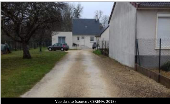
Vue du site (source : CEREMA, 2018)
