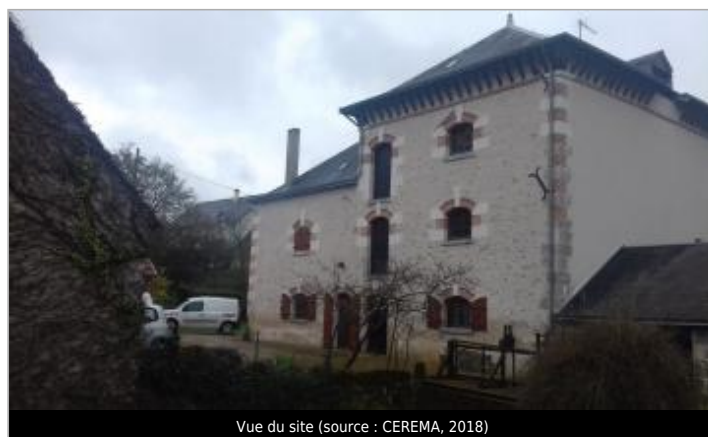
Vue du site (source : CEREMA, 2018)
